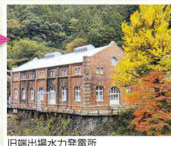
旧端出場水力発電所
