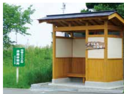
小松庵(西条市小松町南川)
