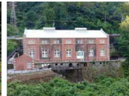
旧端出場 水力発電所
